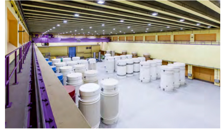
ZWILAG Zwischenlager Würenlingen AG
