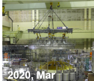
Cryostat Top Lid
