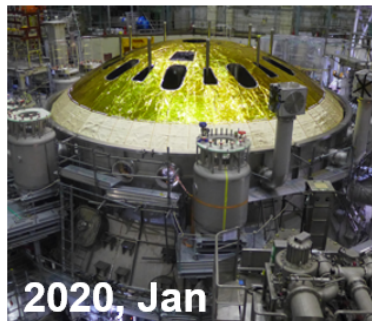
Cryostat Thermal Shield
