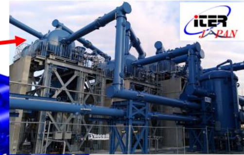
Fig. 14. 1MV AGPS-DC Generator
